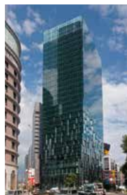
大阪富国生命ビル
